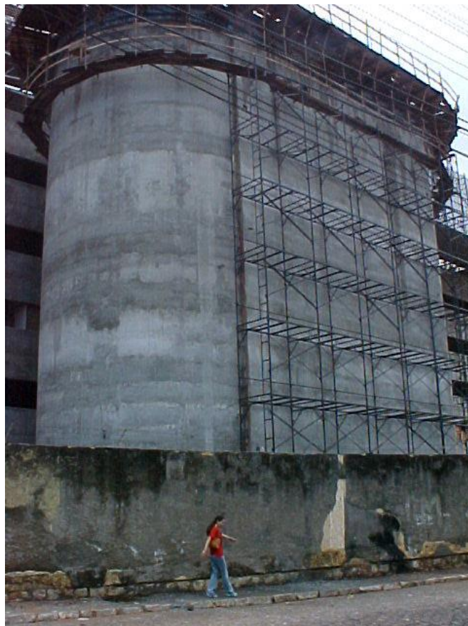
Fig. 3 – Tanque de termoacumulador em construção.
